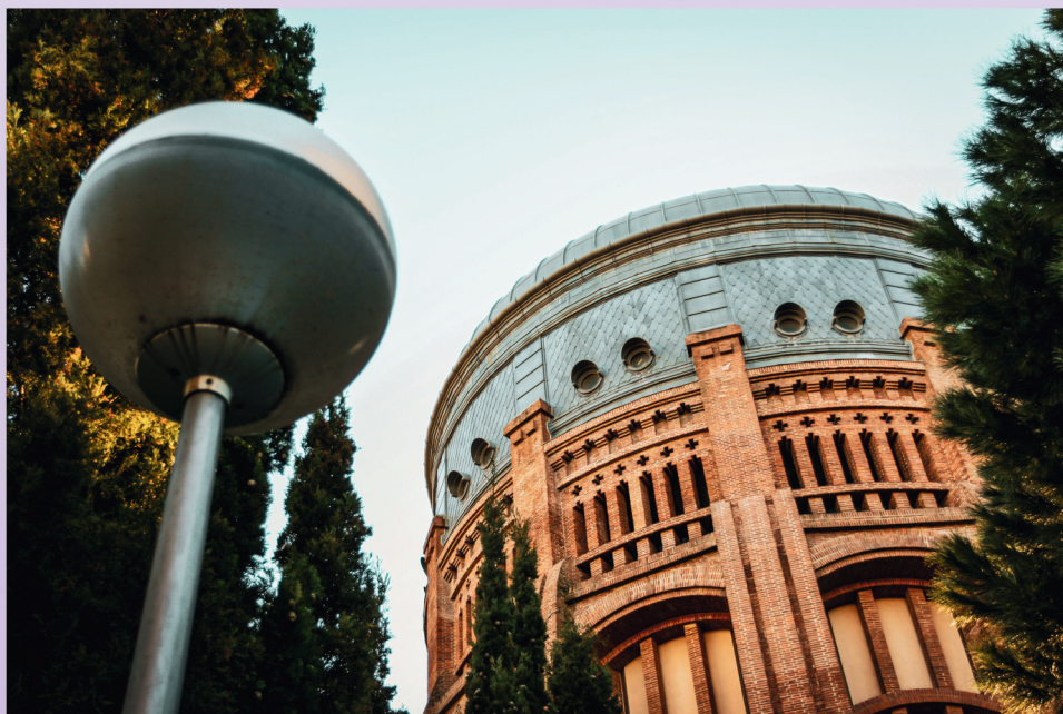
Depósito Canal de Isabel II
